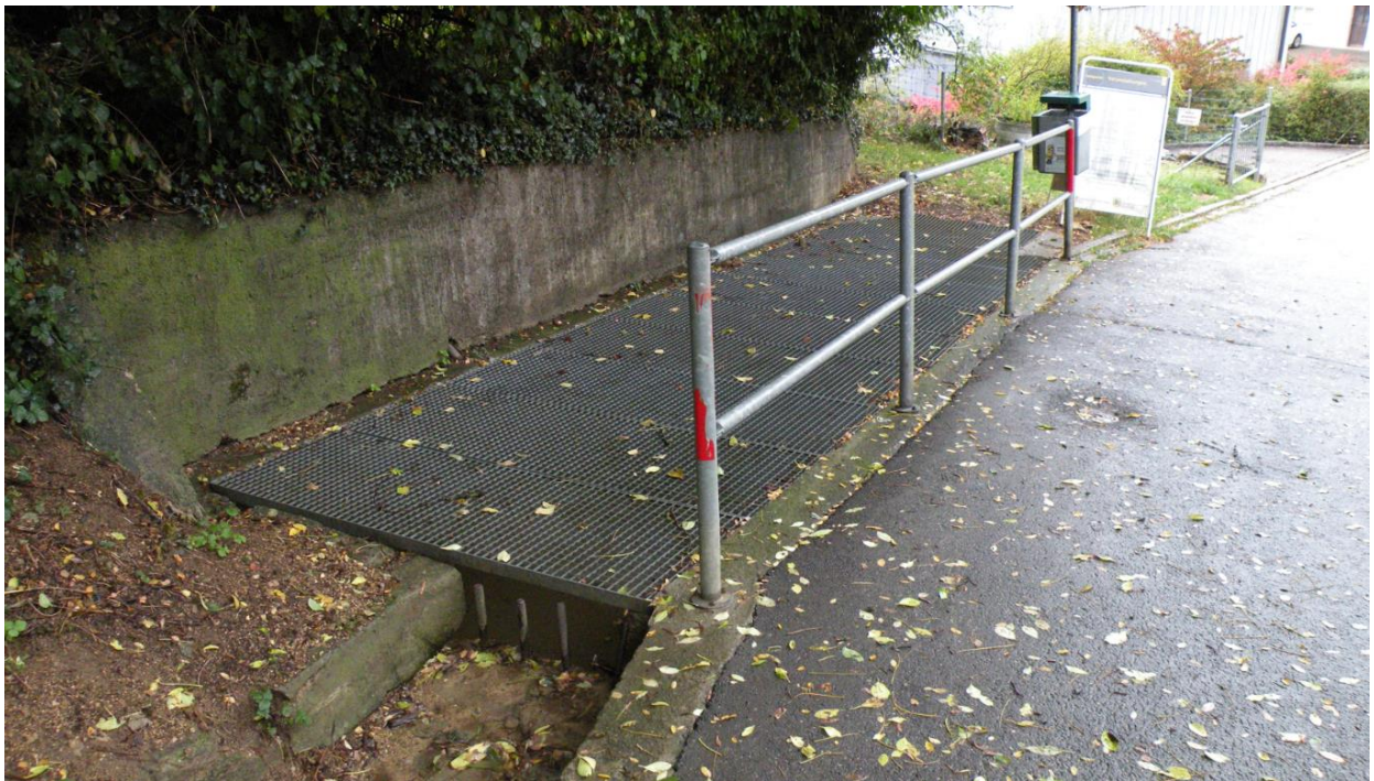
Abbildung 11: Rückhaltebecken vor der Eindolung des Haldenbächlis an der «Hohlen Gasse» (Aufnahme: Joel Hauser)
